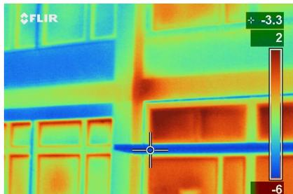
Das neue Fenster notwendig sind, zeigt auch dieses mit einer Wärmebildkamera im vergangenen Dezember aufgenommene Bild: Links der Neubau, „blau“ und damit gut isoliert, dagegen rechts der Altbau, orange bis dunkelrot eingefärbt: Hier geht viel Energie verloren! Das Bild entstand im Rahmen eines Projekts im Technikunterricht Klasse 9 bei Herrn Konold.
